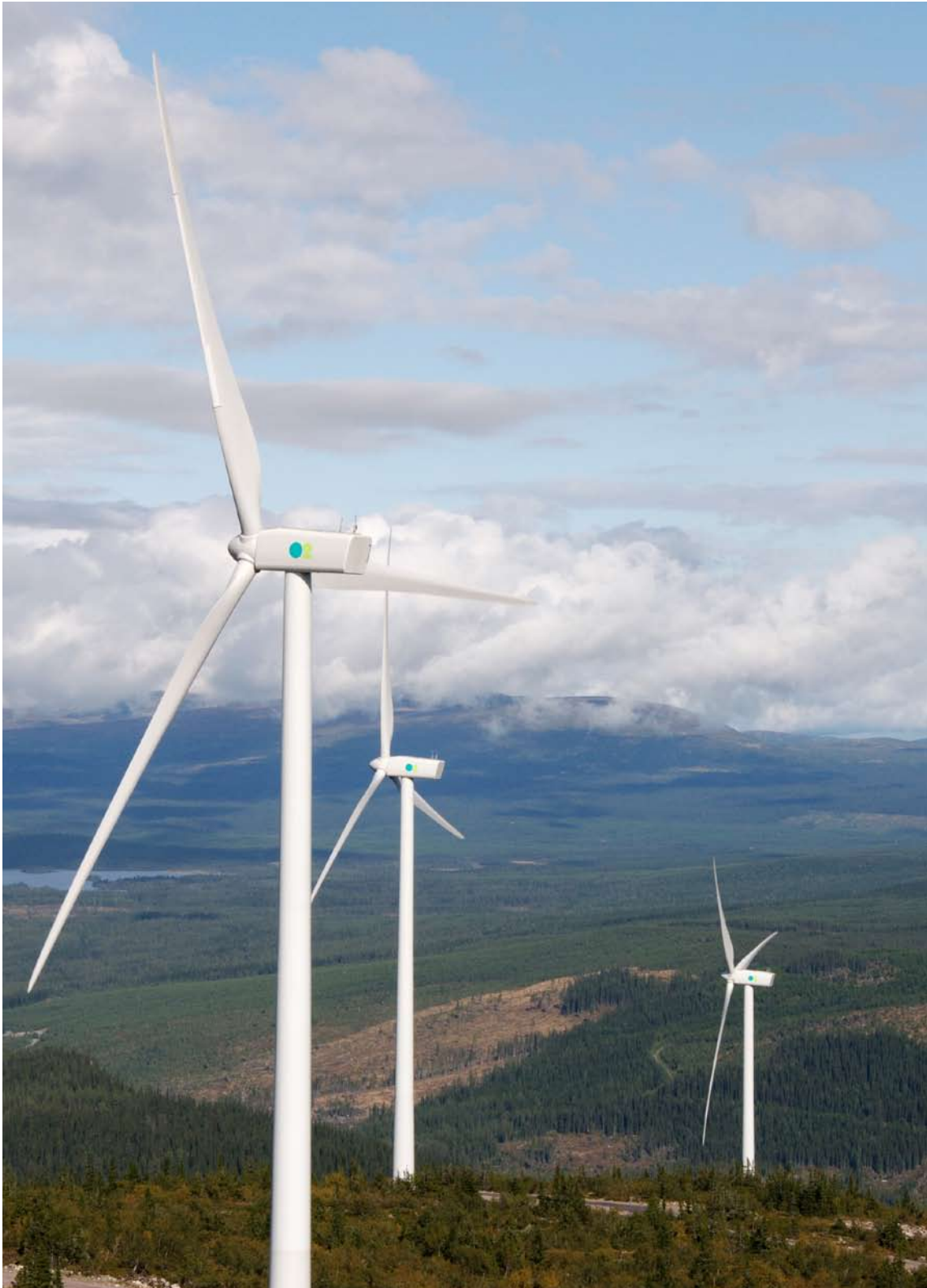
O2 har idag fyra vindkraftparker i drift. Hedbodberget, Säliträdberget, Röbergsfjället och Bliekevare (bilden).
