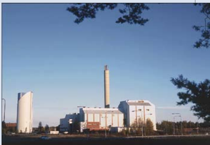
Vattenfalls kraftstation i Idbäcken, Nyköping
