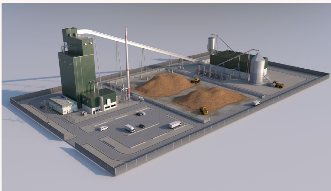
Figur 1: 10 MW BTC anläggning. Källa: Phoenix BioPower
