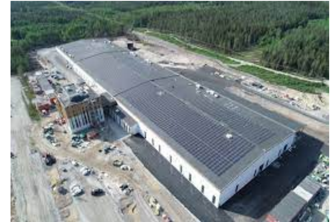
Komatsu Forests tak solcellsanläggning park Installerad effekt: 3 200 KW Installationsår: 2021 Beställare: Komatsu Forest One Öst/Väst system med uppinklat ballastsystem
