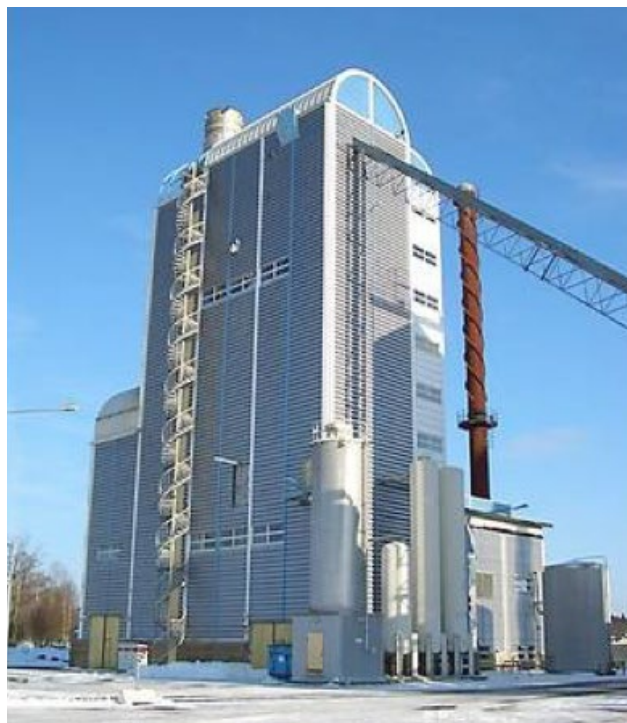
Figur 4: Demonstrationsanläggning för biokraft med gasturbinteknik och förgasning vid Värnamo
