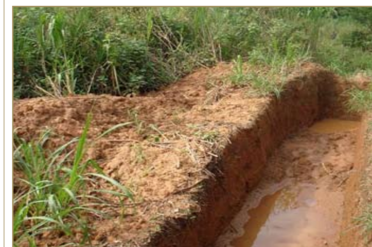
Utgrävning av befintligt anrikningsmaterial från tidigare guldbrytning, sk tailings.
