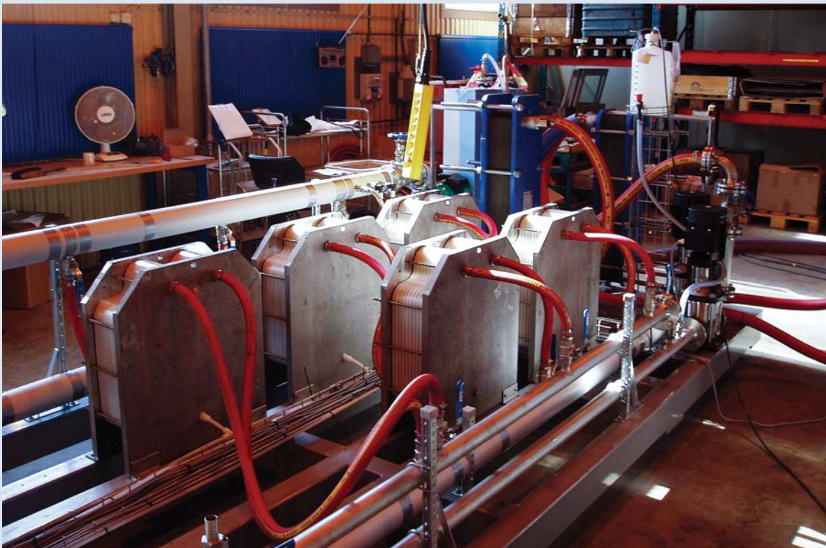
Byggnation av demonstrationsanläggning (10 moduler)
