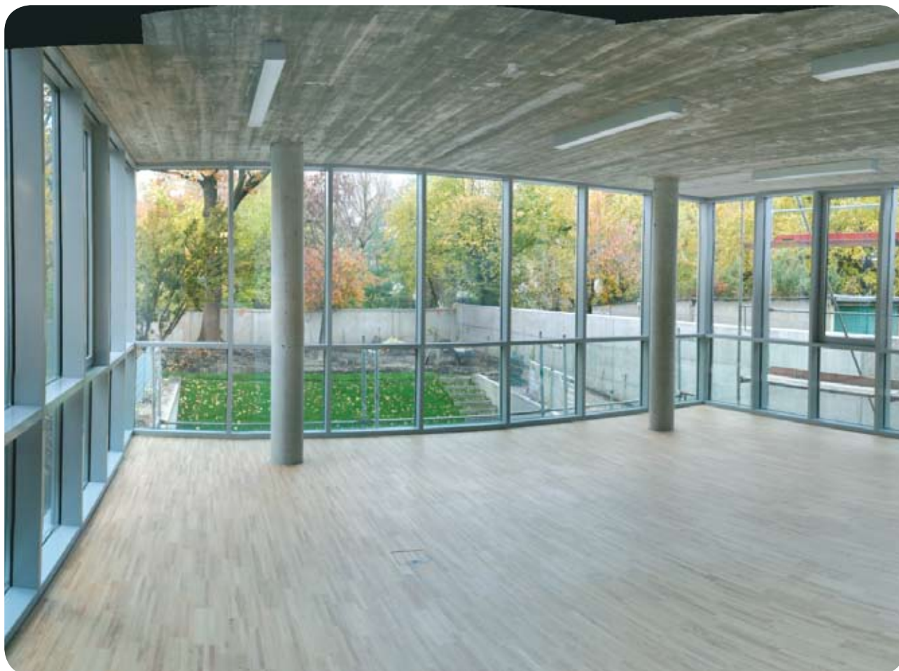
Sammanträdesrum mot gården (sammansatt panoramabild). Installationen av värme, kyla och ventilation är helt osynlig och stjälar ingen plats i rummet.
