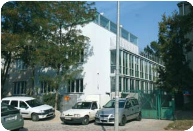
Kontorshus i Warszawa, invigt hösten 2009. Fasaden mot gatan har en traditionell konstruktion medan övriga tre fasader är helt i glas. Rehact Energy System, det intelligenta energisystemet, distribuerar värme, kyla, ventilation och varmvatten i fastigheten.
