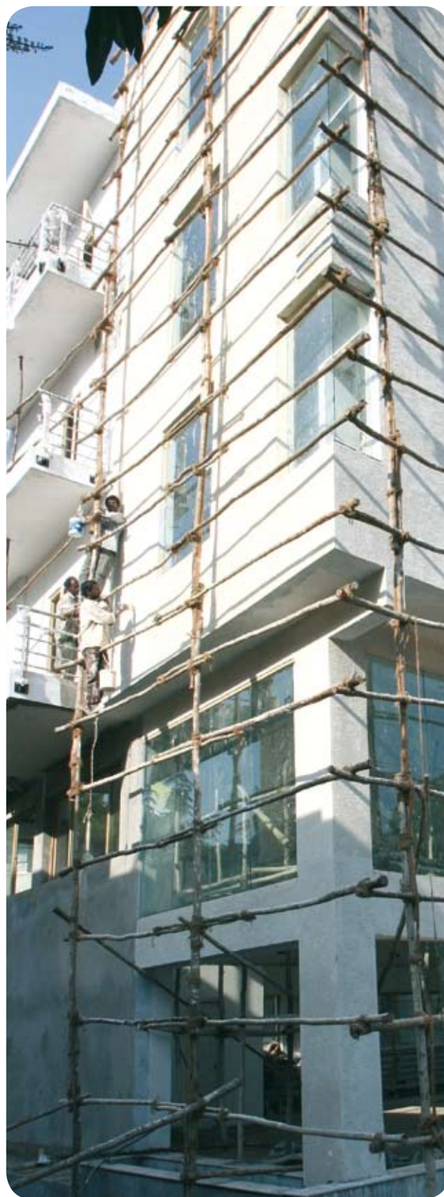
Byggnadsarbete i Bangalore, Indien.
