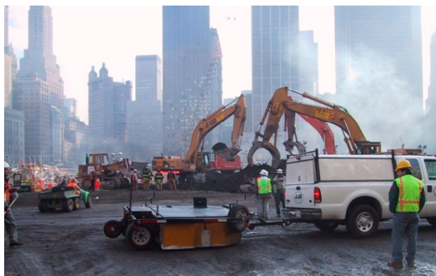
Produkter från Utility Systems används vid Ground Zero i New York.
