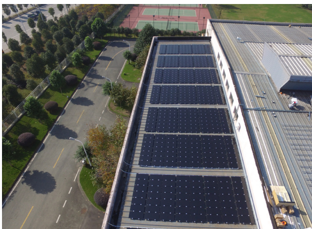
Ebara Great Pumps Co. Ltd. Kapacitet: 3,1 MW Plats: Wenzhou, Zhejiang
