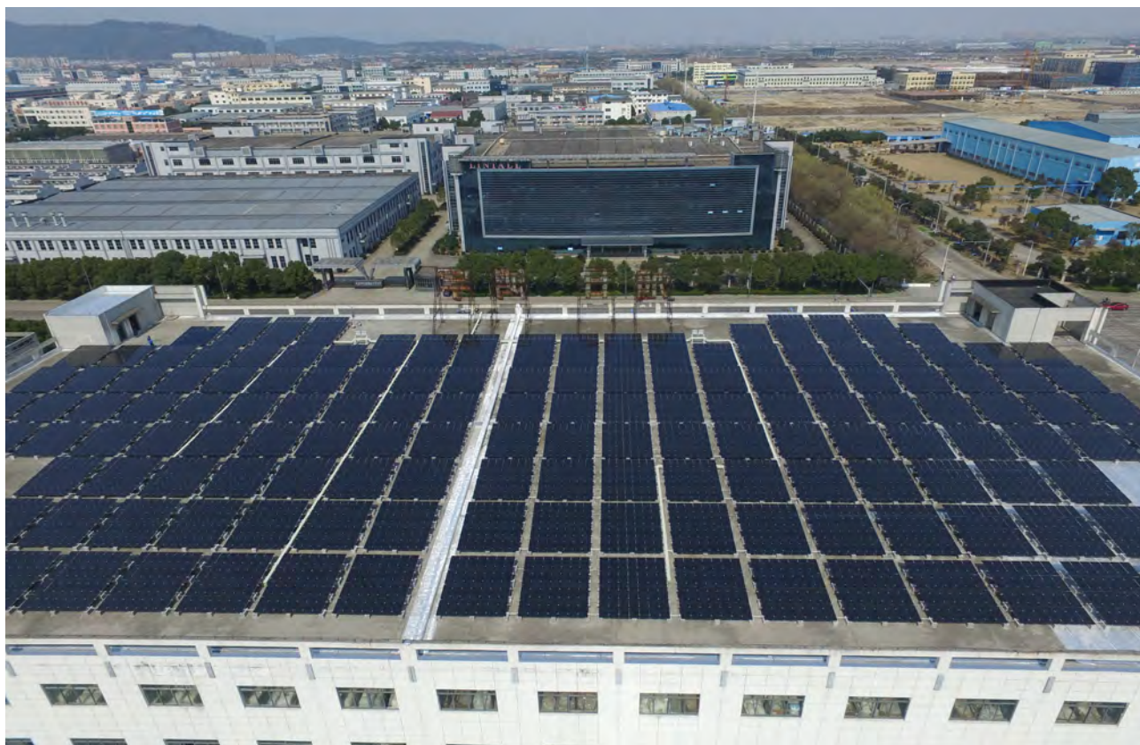
Anläggning om 1,74 MW på Fenghua Xuri Co.Ltd. En av de 128 anläggningar som Bolaget äger i Kina.
