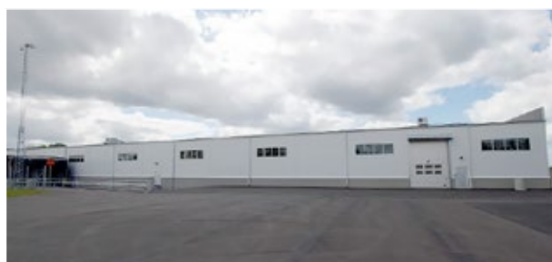
Kolven 1, 3 och 6 i Helsingborg som ligger i Långeberga industriområde och där bland annat ICA har ett av sina centrallager. LMI nyttjar stora delar av lokalerna men har även externa hyresgäster.
