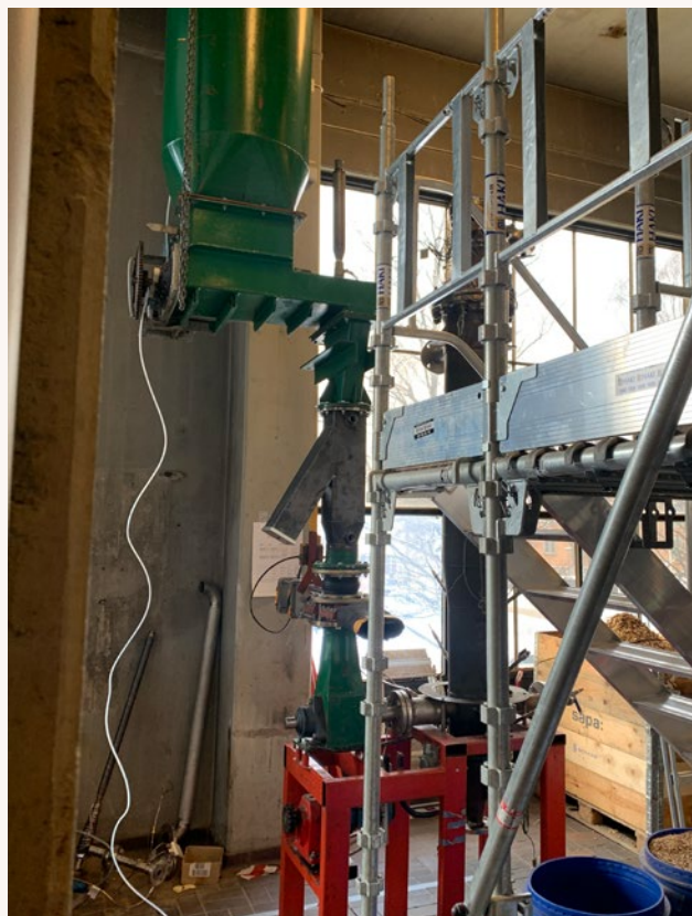
Figur 12: Förgasningsanläggningen till Scarlett under uppbyggnad
