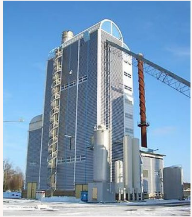
Figur 4: Demonstrationsanläggning för biokraft med gasturbinteknik och förgasning vid Värnamo (källa IEA)
