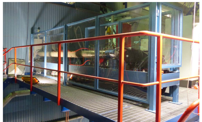
Installationen av Ecotube i Västervik
