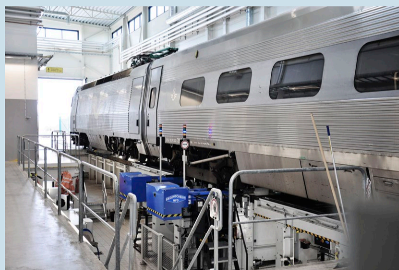
Hjulsvarv vid tågserviceanläggningen i Hallsberg.
