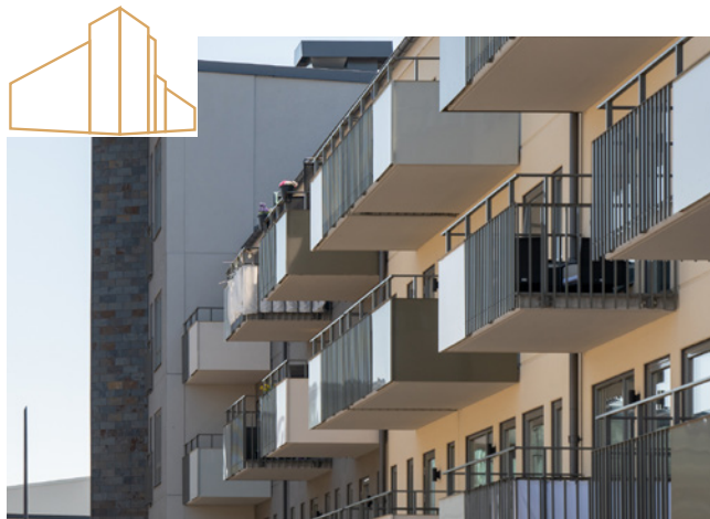
Konstruktionsfakta: Bärande betongkonstruktion med bjälklag och lägenhetsskiljande väggar i betong med utfackningsväggar i en lätt konstruktion.
