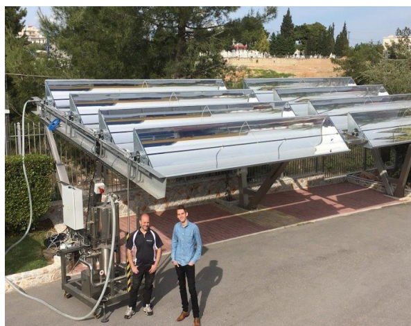
Installation av Absolicons solfångare i Saravanos, Grekland
