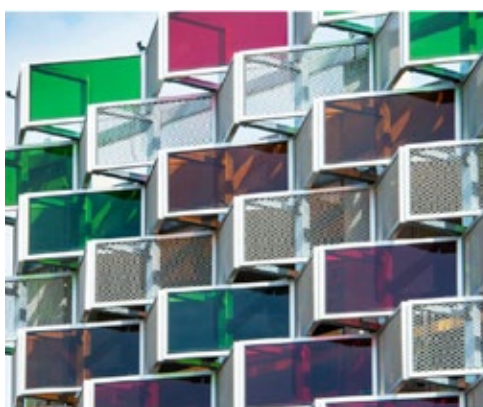
Parkeringshus i Linköping som fått en vacker och funktionell utformning med SolTech ST moduler.
