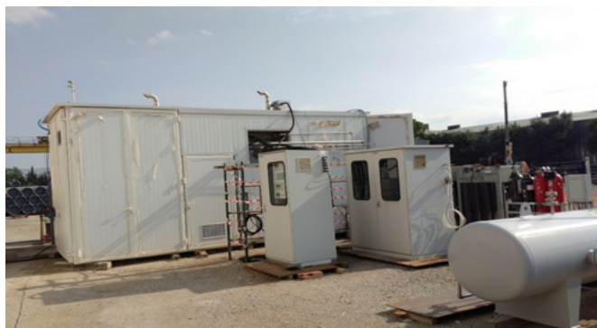
Bilden visar reformern till det 50 kW kraftvärmesystem som idag ingår i AutoRE-systemet i Rugby, England
