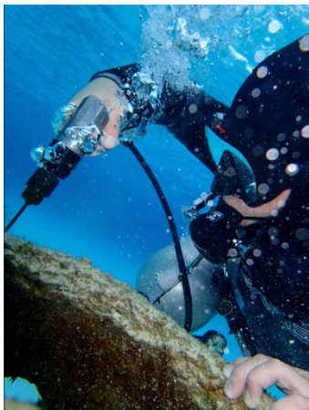
Undervattens hydraulborrmaskin som borrar hål i stenarna för fastsättning av expanderkilar att möjliggöra uppvinning av stenarna
