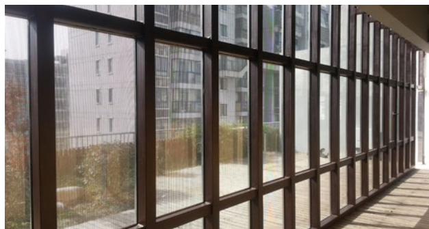
SolTech ST. Bilden visar en vägg helt bestående av semitransparenta tunnfilmssolceller av samma typ som marknadsförs av SolTech på den skandinaviska marknaden.
