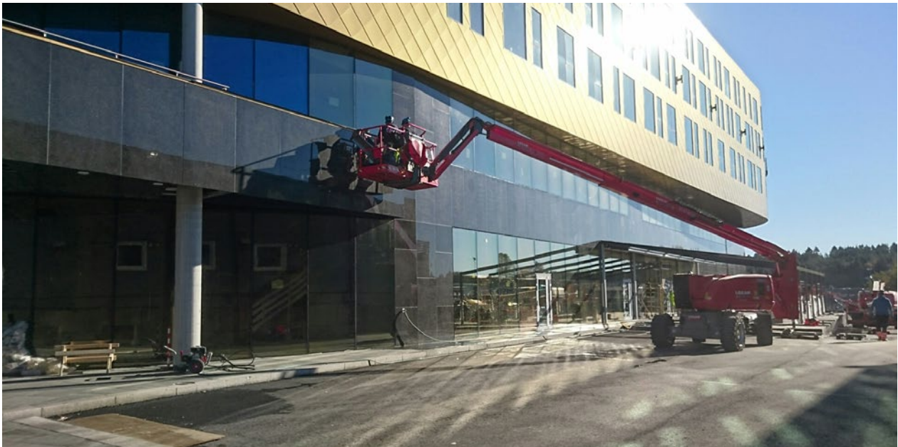
Installation av ConverLight i ett nybyggt hotell i Norge under 2016
