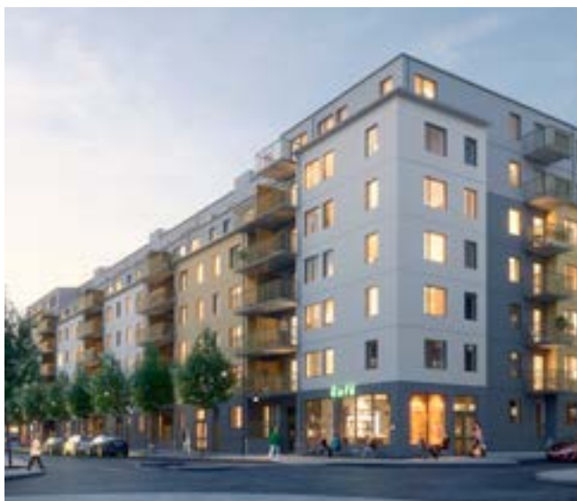
Traversen 18 (till vänster) utvecklades som hyresrättsprojekt, medan Lumen (nedan) utvecklades som bostadsrättsprojekt.
