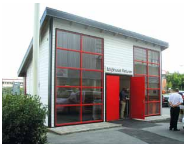
Källsorteringshus hos Renova, Sävénäs, Göteborg
