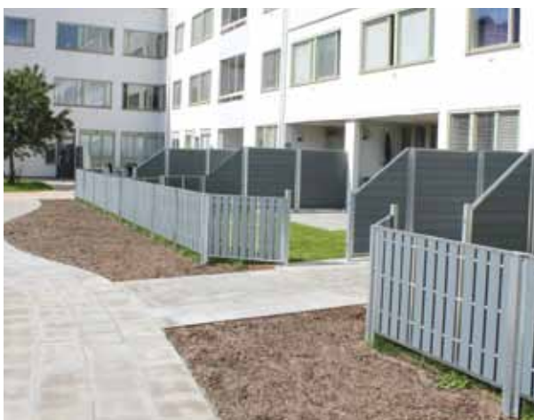
Renovering av uteplatser vid marklägenheter, Lertagsgatan, Örebro.
