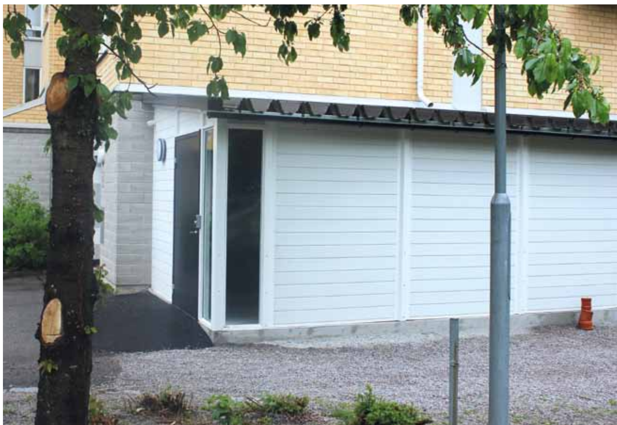
Ett exempel på miljöhus levererat av Polyplank. Beställare av huset var Riksbyggen i Norrköping.
