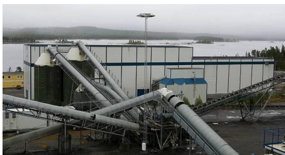
Anrikningsverket vid Ersmarksberget. Bild: Lappland Goldminers
